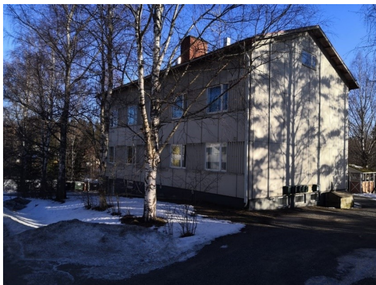
Kuva 4: Tontilla 4910–5 sijaitseva kaksikerroksinen pienkerrostalo. © Tampereen kaupunki 2021
